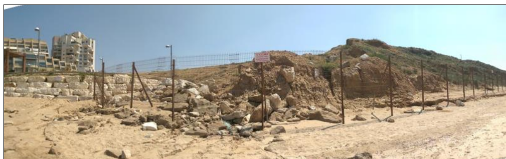
מבט 5 : אי הסדרה של זרימת מי נגר בגמר הפיתוח גרמה לזירוז בליית המצוק
