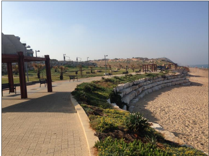
תמונה 1-2.2.4: מדרון מוסדר עם מסלעה בבוהן ובגג המדרון (מבט מכיוון צפון לדרום)
