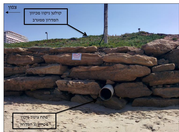
תמונה 2.1.4-8 : פתח צינור ניקוז לנגר מכיוון גג המדרון והטיילת במסלעה (מבט לכיוון מזרח)
