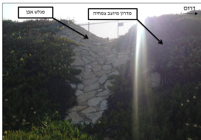
תמונה 2.1.4-3: מגלש אבן לנגר עילי (מבט לכיוון מזרח)
