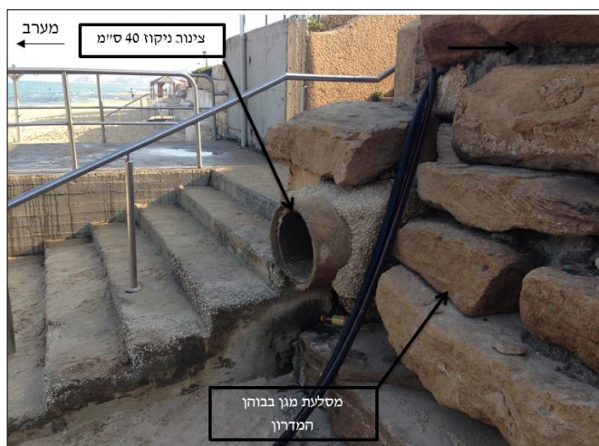
תמונה 2.1.4-4: מוצא צינור ניקוז במסלעה בבוהן המדרון (מבט לכיוון צפון)
