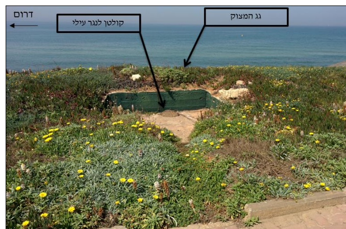
תמונה 2.1.4-7 : קולטן נגר עילי ע"ג גג המדרון בחלקו הדרומי של החוף (מבט לכיוון מערב)
