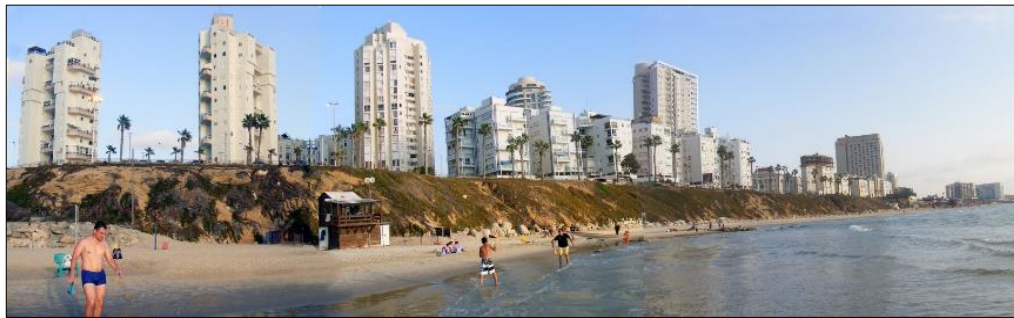
מבט כללי לכיוון דרום. מאופיין במצוק טבעי שבתחתיתו מסלעה נמוכה. המצוק מחורץ עקב נזקי נגר עילי ותשתיות העוברות מחלקו העליון לתחתית המצוק.
