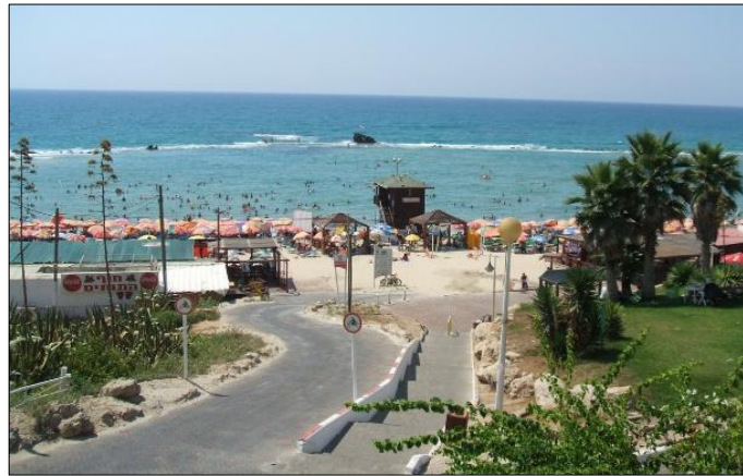
מבט לגישה לחוף לרכב ומדרגות להולכי רגל. אין מעבר נגיש להולכי רגל.
